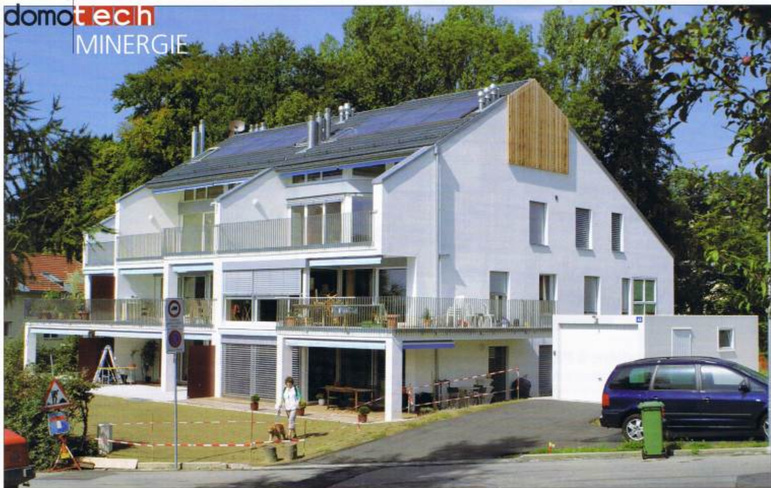
Angle sud-est de "Cigale 8": les deux duplex domotisés occupent les combles et les surcombles.
