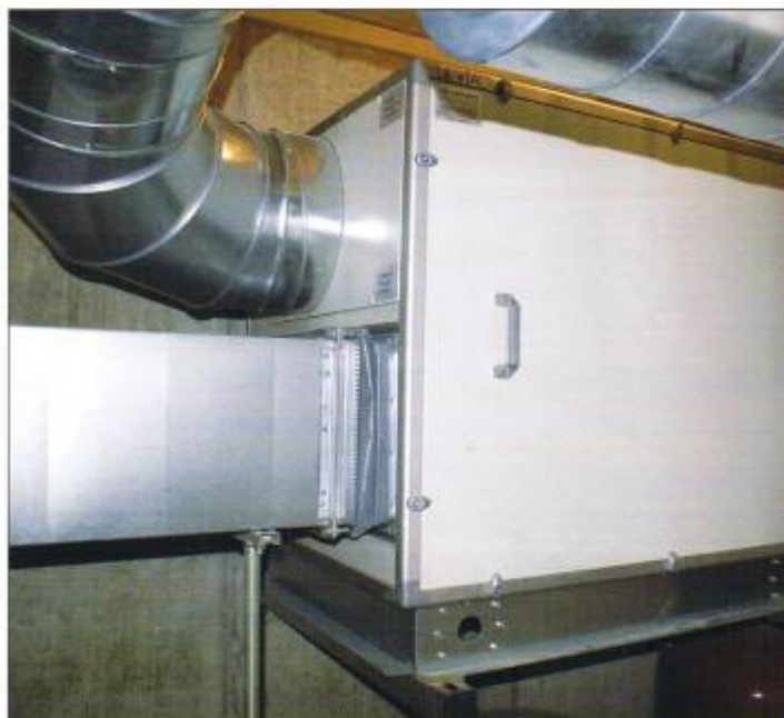
Appareil de récupération de chaleur pour une ventilation confort. Débit d'air en soufflage libre: 800 m 3 /h.
