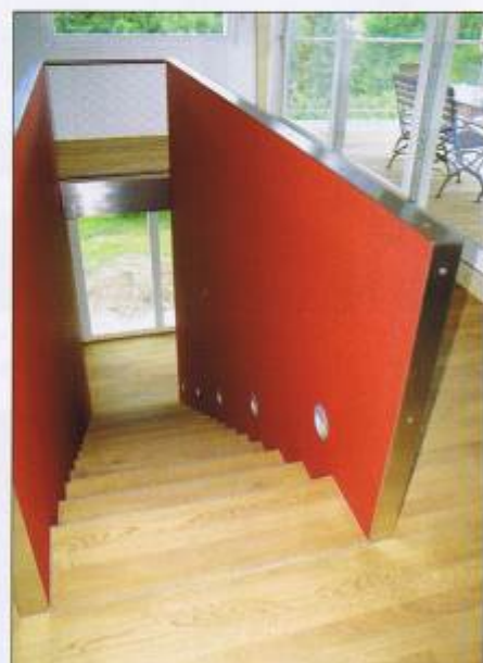
Les escaliers sont équipés d'un système à LED qui permet un éclairage de service à très basse consommation d'énergie.
