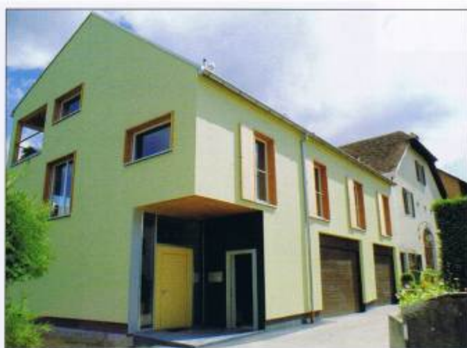
L'entrée principale est située à l'angle nord-est de l'extension.
