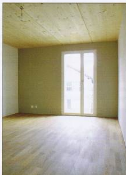
Chambre d'enfant: partout à l'étage les caissons de plancher en épicéa restent visible au plafond tandis que les sols sont revêtus de chêne teinté.
