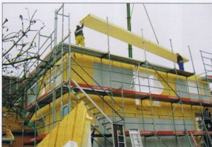
Mise en place des caissons madriers constituant les planchers.
