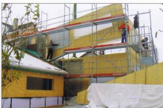
Le gros oeuvre est exclusivement réalisé en bois: modification et extension de la charpente, création des planchers, et réalisation des façades de l'extension en ossature bois (22-11-2007).
