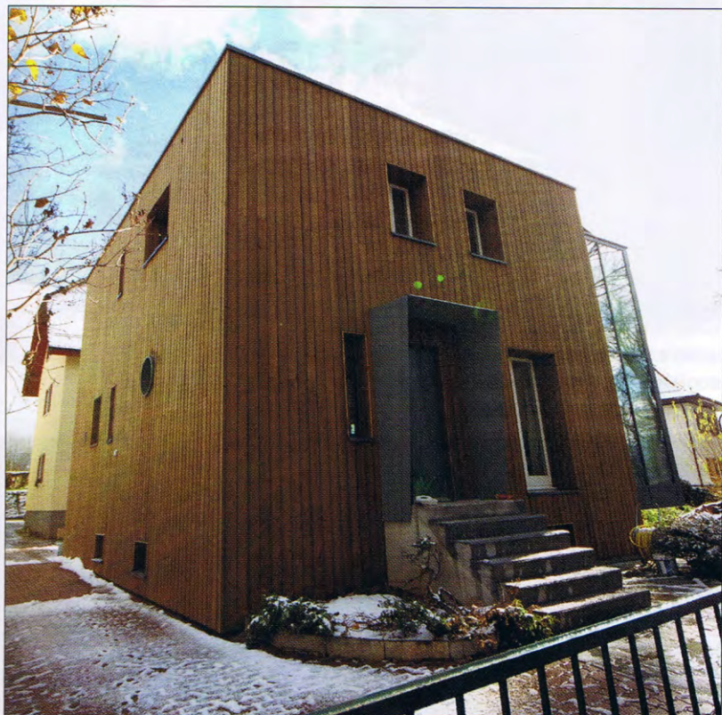
La partie existante a été renovée, isolée et revêtue de bois.
